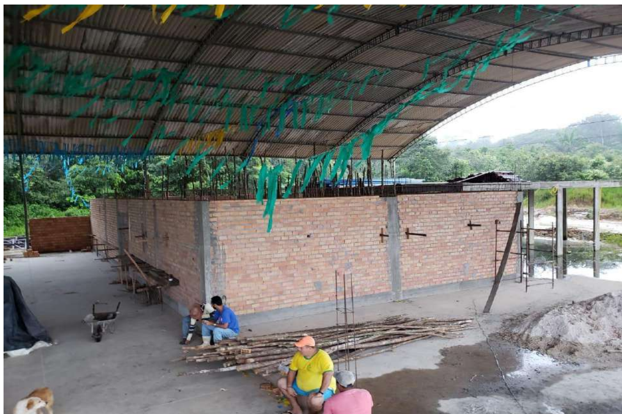
Foto 02: Área Construída Existente
