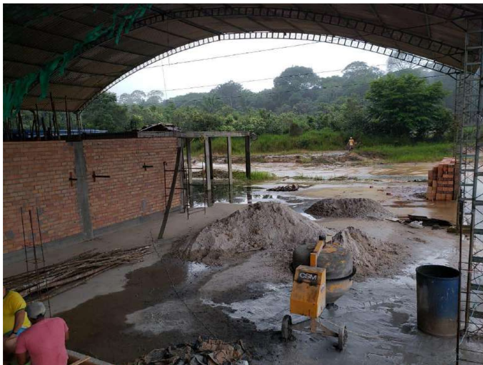
Foto 03: Área Construída Existente.
