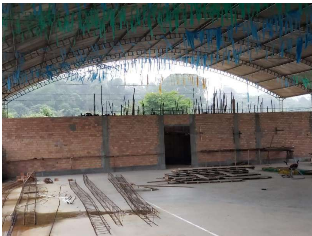
Foto 04: Área Construída Existente
